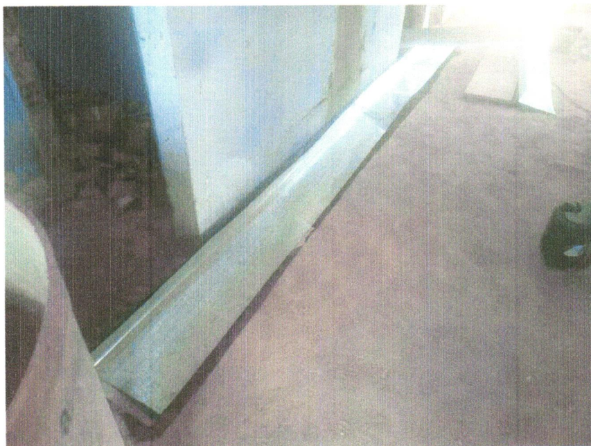
FOTO 02 – Rufo em chapa aço galvanizado nº24 com desenvolvimento 25cm
