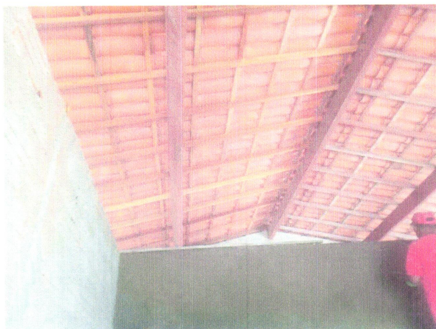
FOTO 08 - Retelhamento em cobertura com telha ceramica tipo canal comum, Itabaiana ou similar.
